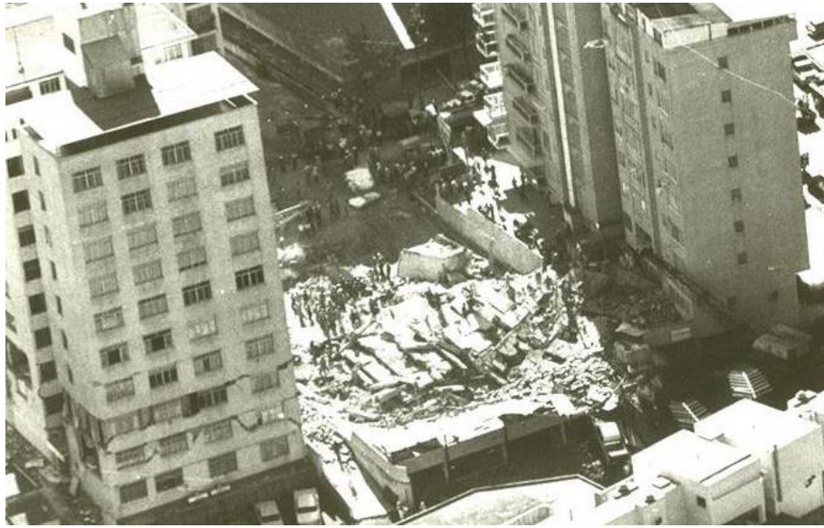
Figura III.7 Colapso del edificio San José (Hanson & Degenkolb, 1969)
