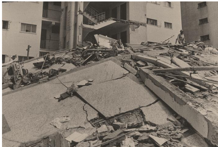
Figura III.12 Colapso del edificio Palace Corvin (Steinbrugge, 1967)
