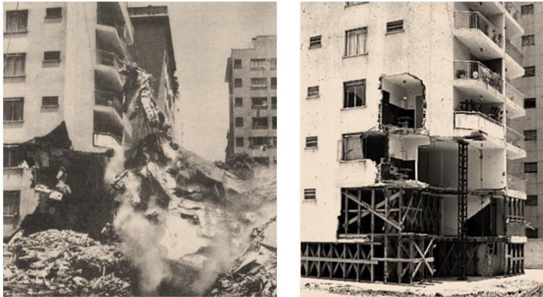
Figura III.17 Daños por impacto del edificio Mijagual sobre el Nobel (Degenkolb & Hanson, 1969)
