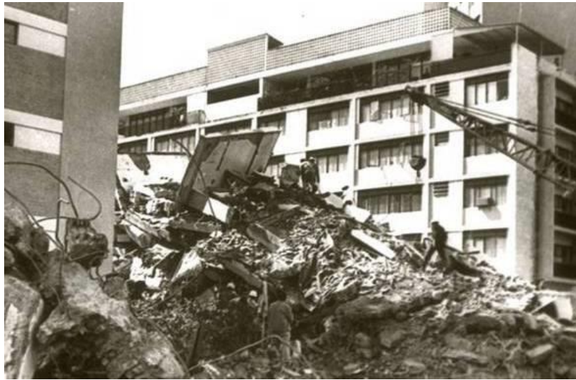
Figura III.5 Colapso del edificio Neverí (Hanson & Degenkolb, 1969)
