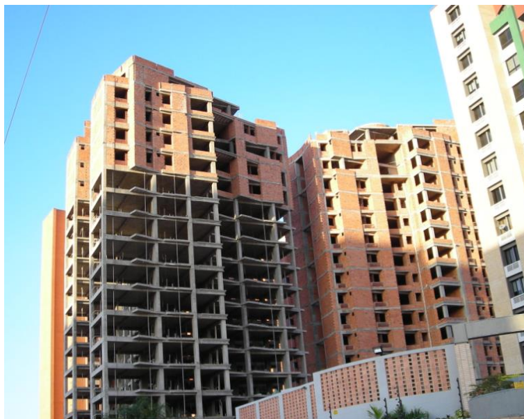
Figura III.4 Edificios típicos en construcción. Foto tomada en febrero de 2011. Se muestra la estructura y las paredes en distintas etapas de construcción
