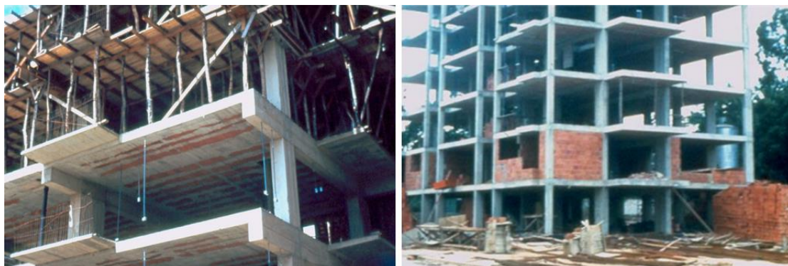
Figura III.3 Edificios típicos en construcción. Año 1967 (Fintel, Nieves, Jobse, Armheim, & Griffin, 1967)
