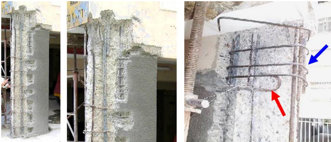
Figura III.22 Edificio Belaire, detalles de armados
