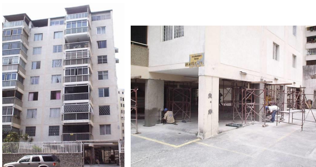
Figura III.20 Edificio Belaire, fachada sureste
