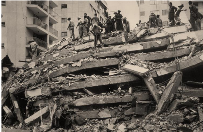
Figura III.10 Colapso del edificio Mijagual (Valois, 1967)
