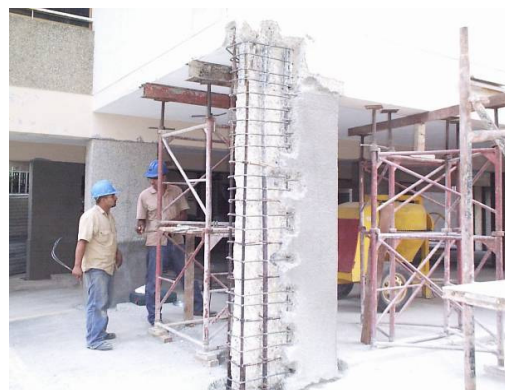
Acero de confinamiento añadido durante la reparación.
