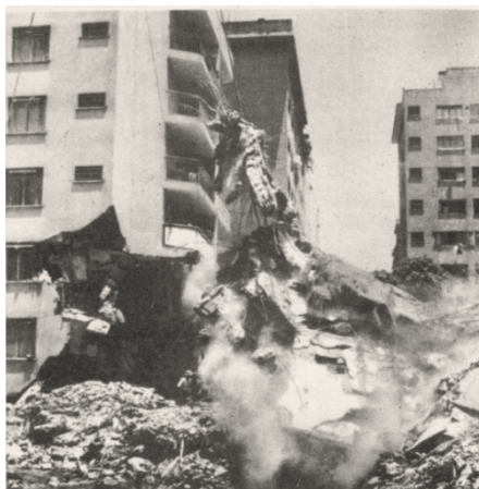
Colapso de Mijagual sobre Nobel (Degenkolb & Hanson, 1969).
