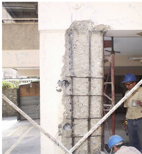
Detalle columna escarificada. Sin acero de confinamiento en porción superior.
