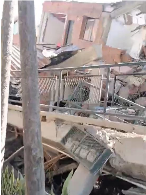
Edificio antiguo colegio Pio XII
