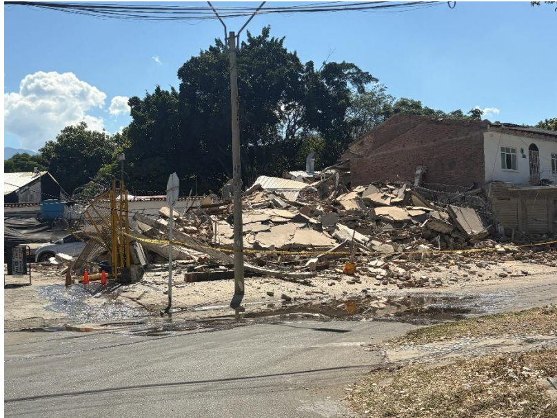
Edificio Av. Roosevelt con 46
