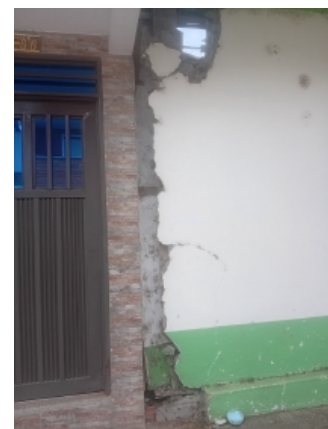
(c) Fallas junto a la estructura colindante
