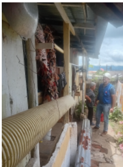
(a) Sistema estructural de Porticos de Madera
