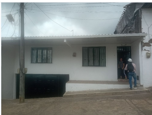
(a) Vista frontal de la estructura. Se evidencia la estructura colindante.
