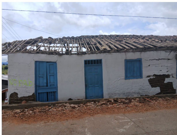
(a) Vista exterior de la estructura afectada.
