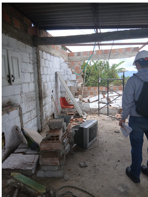
(a) Vista interior de la estructura afectada.
