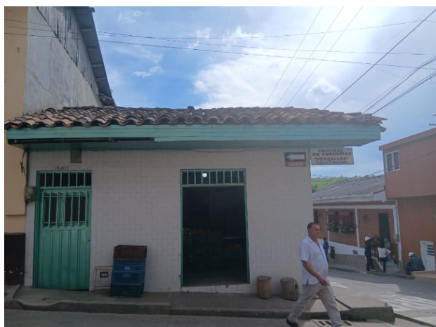
(a) Vista exterior de la estructura afectada
