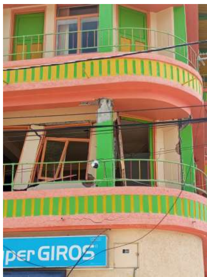
(b) Fallas en nodo columna-viga (ausencia de estribos).
