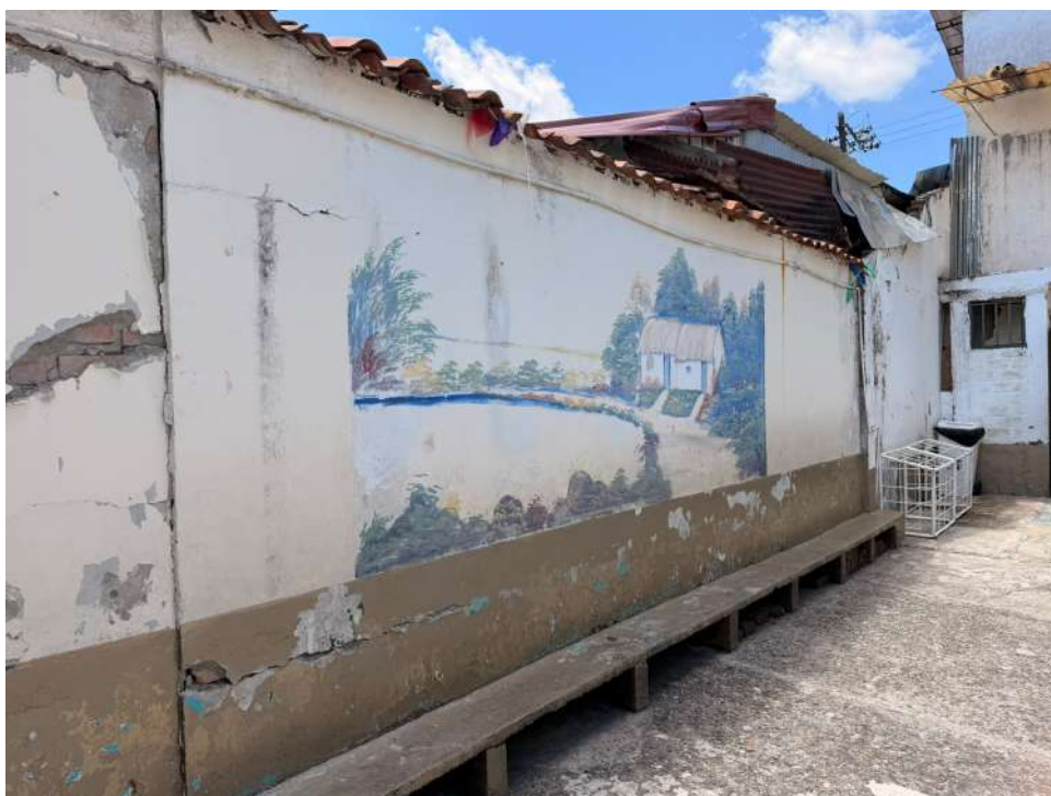
Figura 3. Muro exterior del patio escolar.
