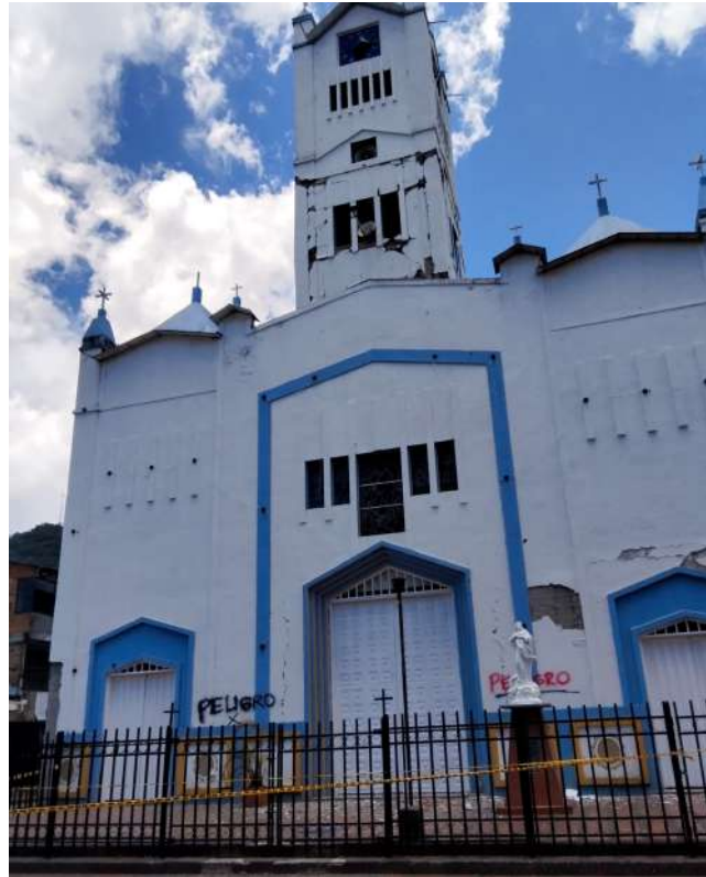
Figura 7. Vista frontal de la iglesia.
