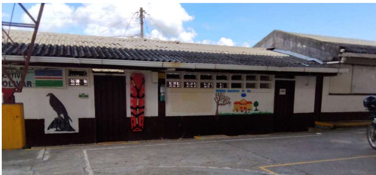
Figura 1. Institución Educativa El Águila (Primer bloque de aulas).
