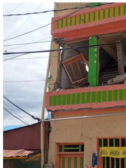
(c) Fallas en nodo columna-viga (ausencia de estribos).
