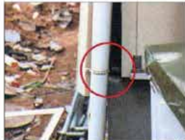
アンカーボルトの伸びが見られる。
