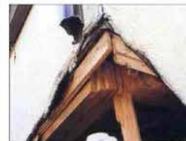
柱、梁に著しい損傷が生じており、交換が必要である。
