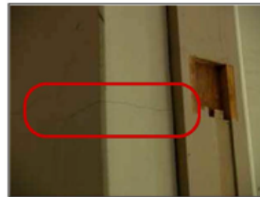
近寄らないと見えにくい程度のひび割れ(幅約0.2mm以下)が生じている。
