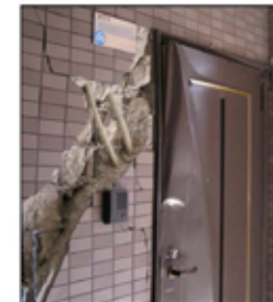
【雑壁】 全体が変形し、仕上の大部分が剥離している。
