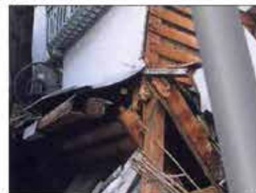
柱、梁の割れ、断面欠損が著しい。
