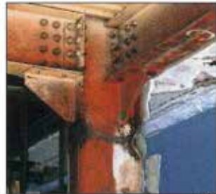
局部座屈による中ぐらゐの変形が柱に見られる。
