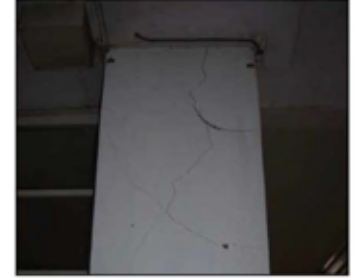
肉眼ではっきりと見える程度のひび割れ(幅約0.2mm～1mm)が生じているが、コンクリートの剥落は生じていない。
