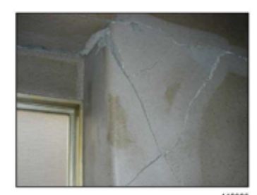
比較的大きなひび割れ(幅約1mm～2mm)が生じているが、コンクリートの剥落は増わずで、鉄筋は露出していない。
