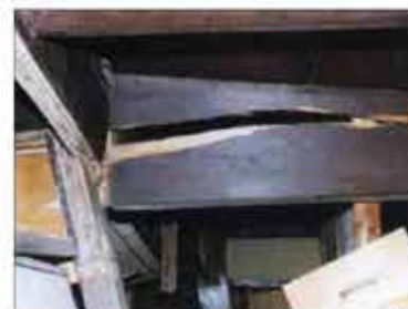
柱、梁に大きな割れが見られる。
