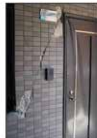
【雑壁】 全体にひび割れ(幅約0.2mm～1mm)やはがれが生じている。
