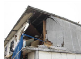
写真6.2.6-2 2階表壁の損傷
