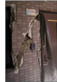
【雑壁】 全体にひび割れ(幅約1mm～5mm)やはがれが生じている。
