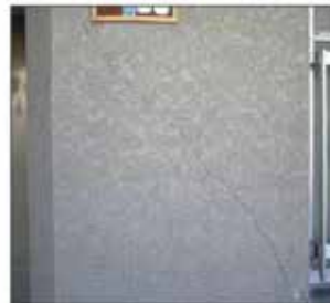
【雑壁】 一部にひび割れ(幅約0.2mm～1mm)やはがれが生じている。
