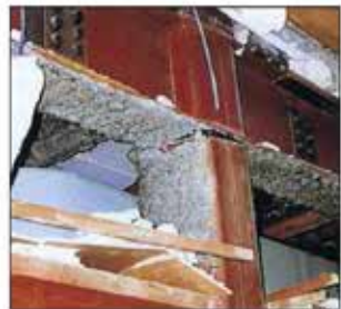
接合部の破断が見られる。
