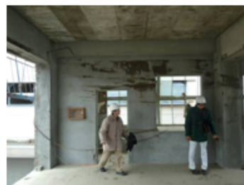
写真3 建物1階の浸水痕
