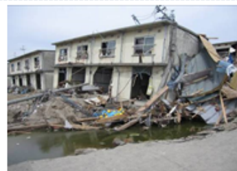
写真6.2.6-1 周辺地盤の洗掘による傾斜
