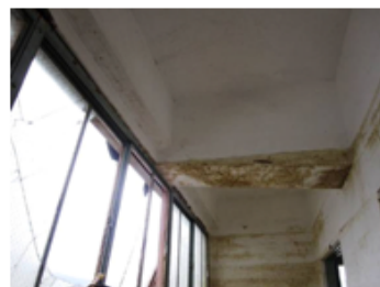
写真4 建物1階の浸水痕
