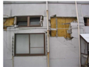
【外部仕上】 仕上材の破壊、脱落が一部見られる。
