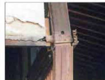
柱、梁の仕口になずれが見られる。
