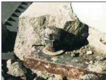
アンカーボルトの伸びが見られる。
