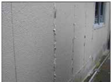
【外部仕上】 仕上やパネルの目地にはっきりとしたひび割れが見られる。仕上材が部分的に剥離している。
