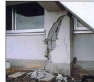
大きなひび割れ(2mmを超える)が多数生じ、コンクリートの剥落も激しい。鉄筋が露出しているが、鉄筋の変形は見られない。
