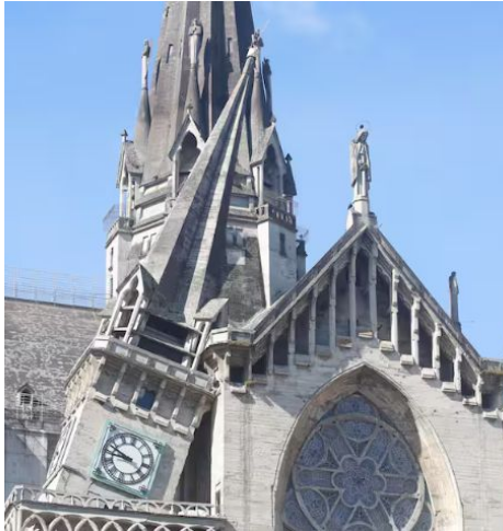
Tilting of one of the towers of Cathedral Basílica Metropolitana de Nuestra Señora del Rosario in Manizales, Caldas region Photo: John Jairo Bonilla/EFE. Source: El Espectador [4].
