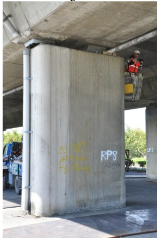
(d) Bridge damage inspection process
